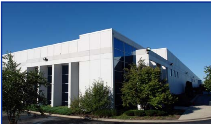
305 Crossroads Pkwy, Bolingbrook
